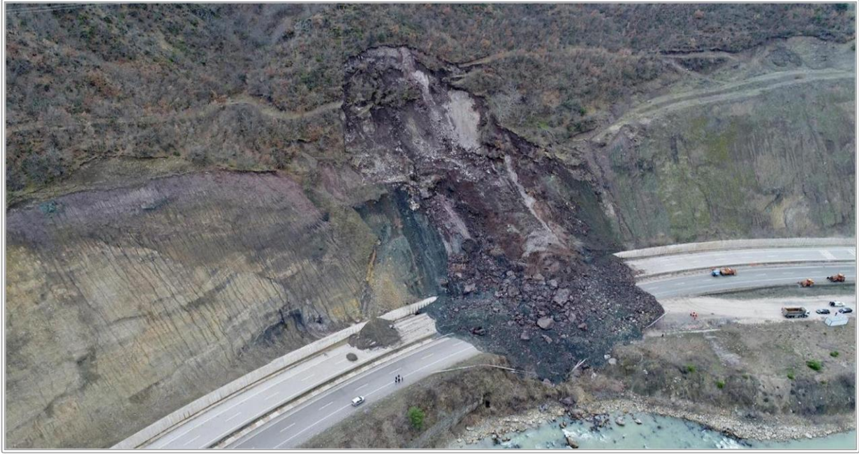
Resim 1.2: Niksar-Reşadiye Karayolu Üzerindeki Heyelandan Görünüm*
