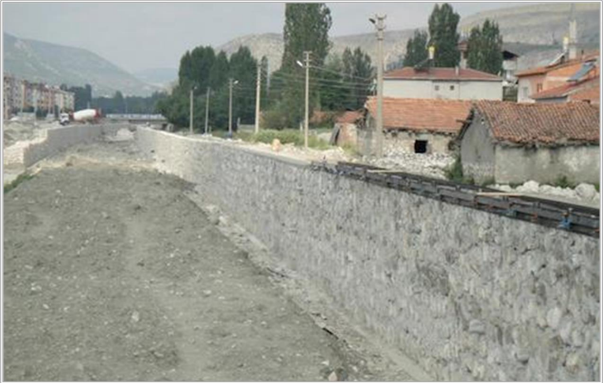
Resim 2.15: Tokat İli Turhal Merkezinden Geçen Yapılmış Islah Çalışması (DSİ 72. Şube Müdürlüğü, 2019)
