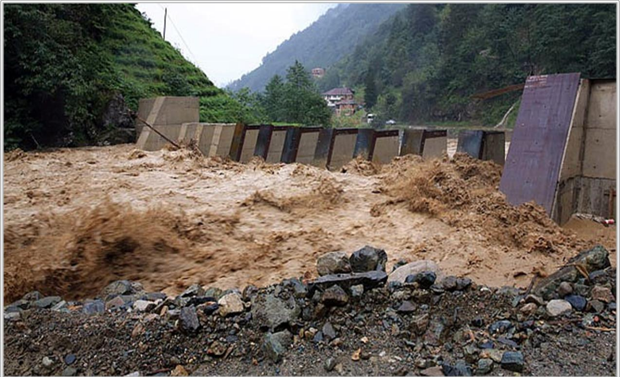
Resim 2.19: DSİ tarafından Rize İli Güneysu İlçesinde Yapılmış Örnek Islah Çalışması (DSİ Genel Müdürlüğü, 2019)
