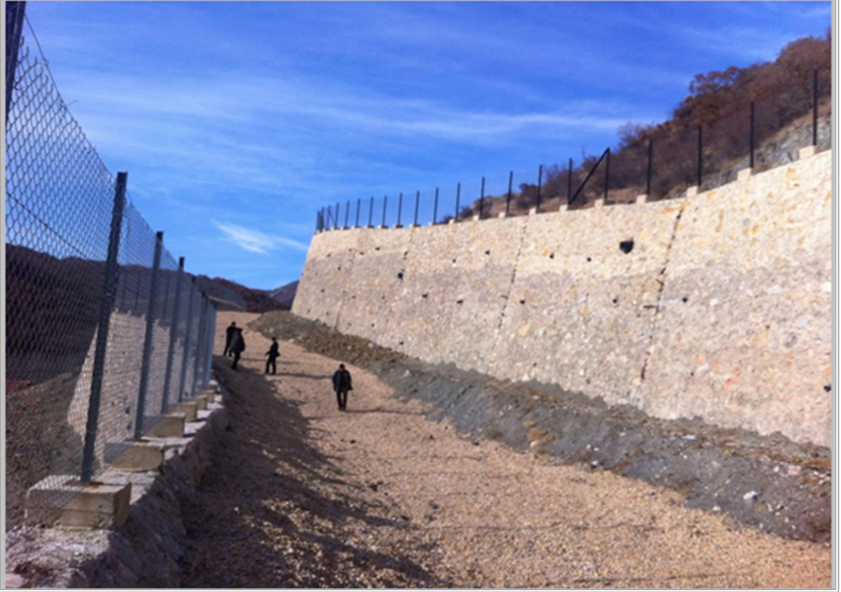
Resim 2.11: Merkez, Gökçe Köyü, Kaya Düşmesi Islah Projesi İstinat Duvarı*
